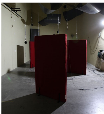
foto : 3 Acousticomfort panelen van 1600x900mm met stoffen bekleding.
